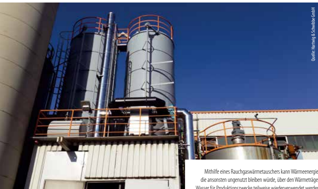
Ein Pufferspeicher mit einem Fassungsvermögen von 18.000 Litern kann anfallende Prozesswärme aufnehmen und zur Wiederverwendung bereitstellen
