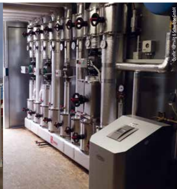
Dank der modularen Bauweise lässt sich die Anlage abbauen, transportieren und für andere Werke oder Anwendungen nutzen
